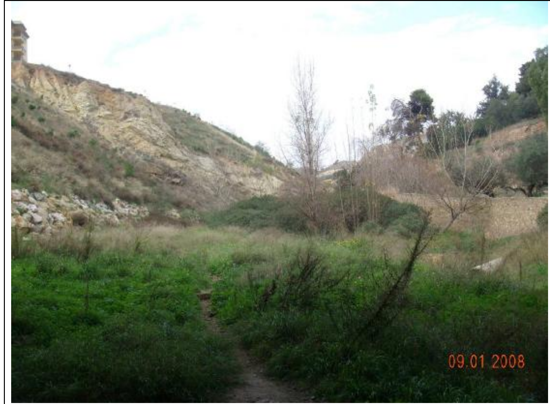
Fotografía 5 – Al norte de la estructura el cauce continua bien conformado.
