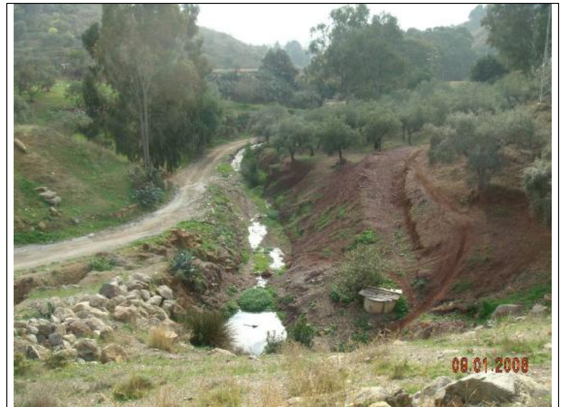
Fotografía 12 – Situados encima de la obra de drenaje mostrada en la fotografía anterior, vemos como desciende el cauce hacia aguas abajo.
