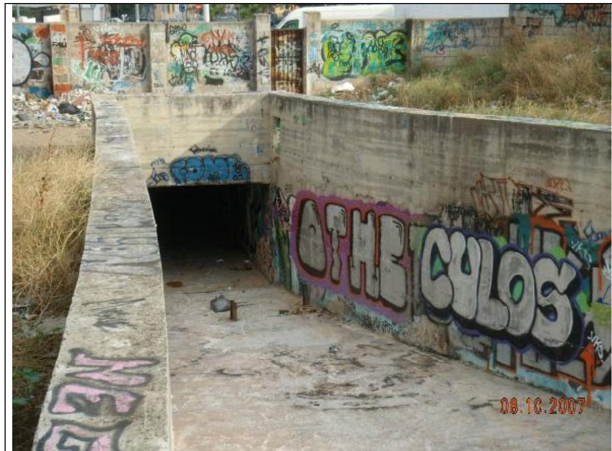
Fotografía 2 – Una vista de la embocadura del embovedado con dimensión de 3,0 x 2,5 m
