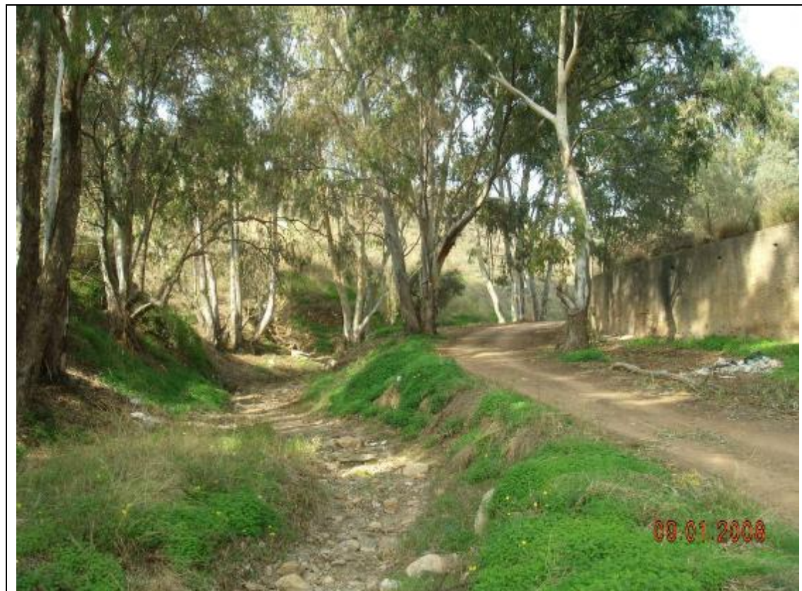
Fotografía 14 – De regreso hacia la ciudad, en una posición intermedia entre la que teníamos cuando tomamos las fotografías 8 y 11, hemos tomado dos del cauce; esta hacia aguas arriba que nos muestra su razonable discurrir en un entorno de eucaliptos.
