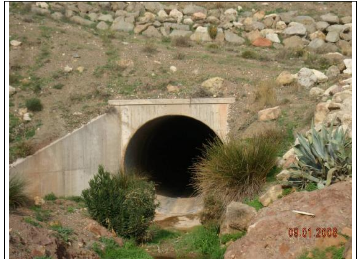
Fotografía11 – Con este tubo ARMCO, de importante diámetro, cruza el cauce principal la A-7.
