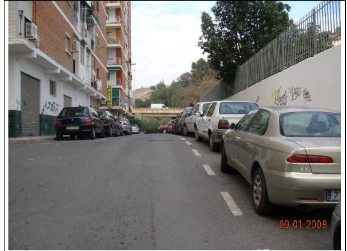
Fotografía 7 – Al fondo vemos el vial transversal. La fuerte pendiente del vial en el que nos encontramos no propicia el vertido de la escorrentía hacia el cauce que está a la derecha.
